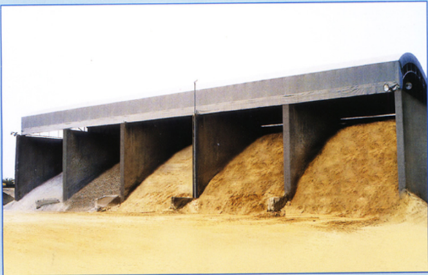
● 골재 투입 흙퍼 지붕 시설 ●
